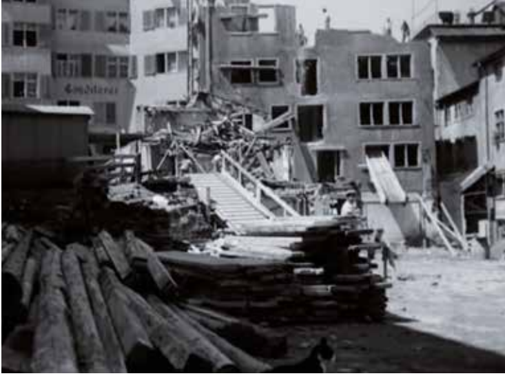
Abb. 1: Der Abriss eng gebauter Altsiedlungshäuser dient in ZÜRICH BAUT sowohl der Umsetzung des neuen architektonischen Programms – Luft, Sonne, Raum – als auch der Arbeitsbeschaffung für die Bevölkerung.
